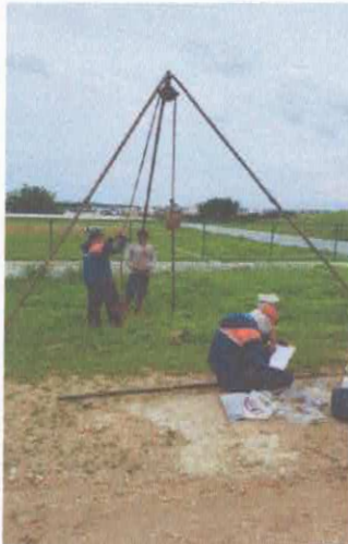
Ensaio de Standart Penetration Test - SPT
