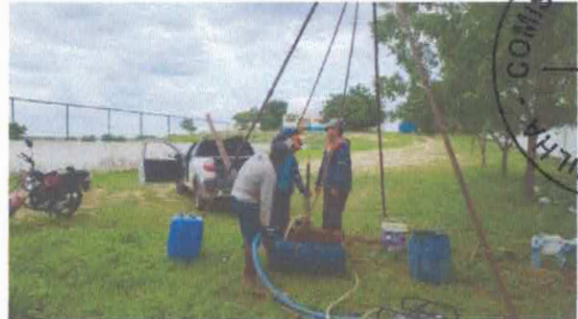
Avanço pelo metodo de lavagem, com utilização do trépano de lavagem
