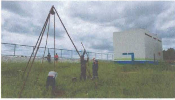
Montagem das hastas para inicio da sondagem percussiva SP 01 -EST
