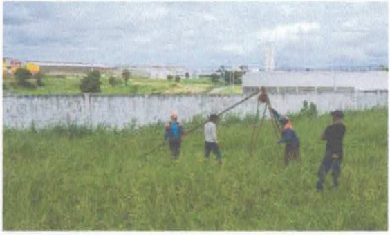
Montagem da torre ou tripé da percussiva
