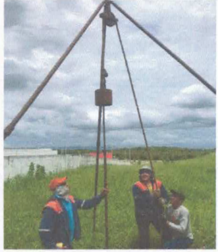
Ensaio de Standart Penetration Test - SPT
