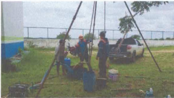
Avanço pelo metodo de lavagem, com utilização do trépano de lavagem
