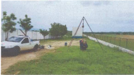
Ensaio de Standart Penetration Test - SPT
