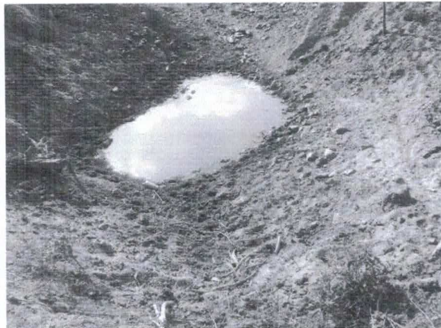
FOTO 1 – VISTA DO TALVEGUE DA BARRAGEM
