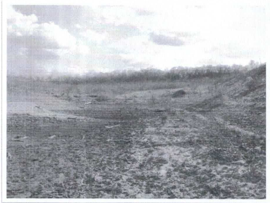
FOTO 3 - VISTA DA JUSANTE DA BARRAGEM
