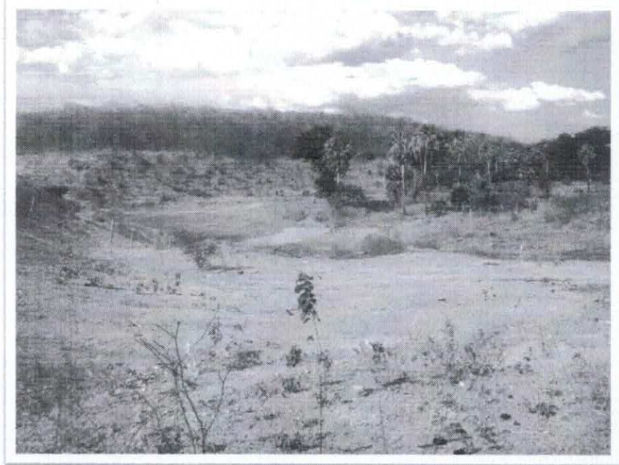
FOTO 4 - VISTA DA MONTANTE DA BARRAGEM II
