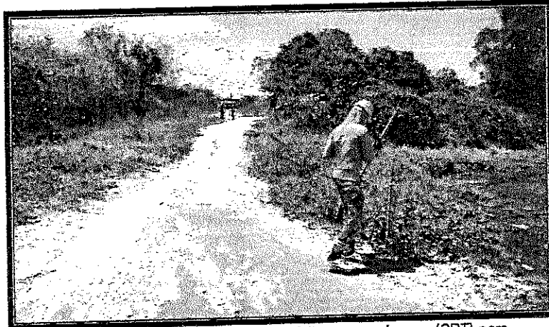
Foto 1 – Visão parcial da área onde foram feitas as sondagens (SPT) para construção da Passagem Molhada na localidade de Bom Lugar, Forquilha/CE
